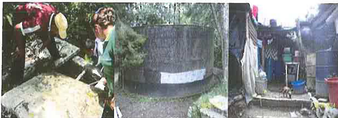
ILUSTRACIÓN 18: CAJAS DE CAPTACIÓN Y SISTEMAS DE ALMACENAMIENTO DEL AGUA LLUVIA EN RI.
