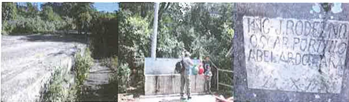
ILUSTRACIÓN 48: SISTEMA DE ABASTECIMIENTO DE AGUA POR ESCURRIMIENTO EN EL CASERÍO LA CASCAJERA Y OJO DE AGUA DEL CANTÓN EL PROGRESO. FUE CONSTRUIDO EN 1954.
