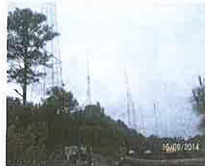
ILUSTRACIÓN 45: RED DE ANTENAS DE RADIO Y TELECOMUNICACIONES EN PERÍMETRO DEL ANP
