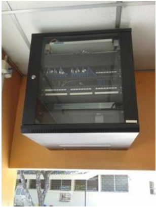
INSTALACION DE 185 PUNTOS DE RED PARA EL SIAP
