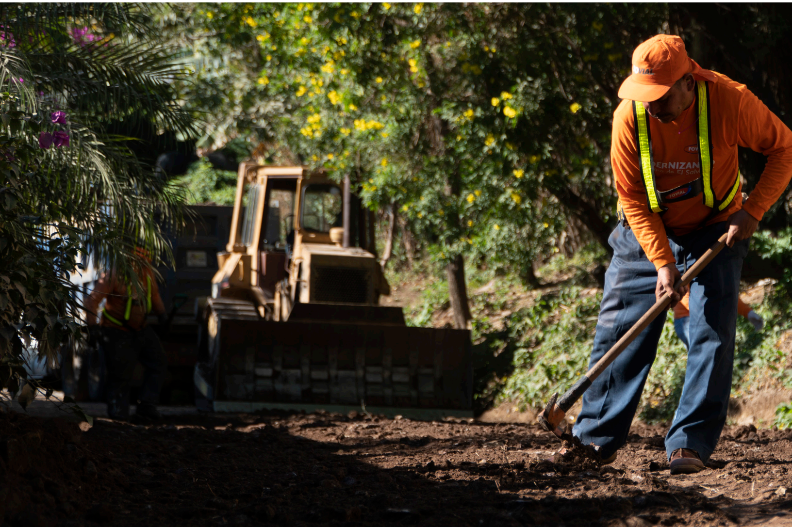
Mantenimiento rutinario de vías no pavimentadas, Cabañas
