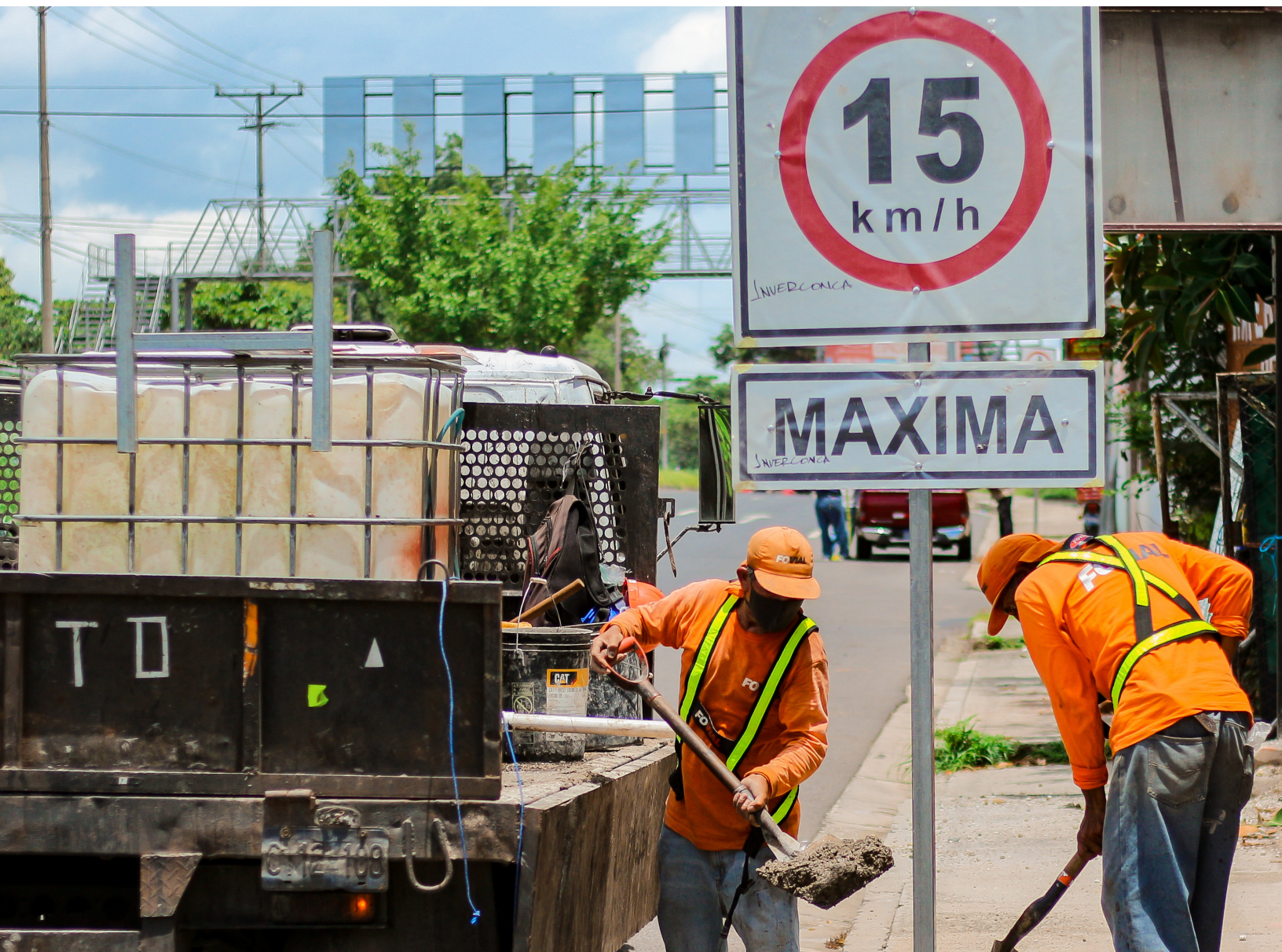
Instalación de señal vertical
