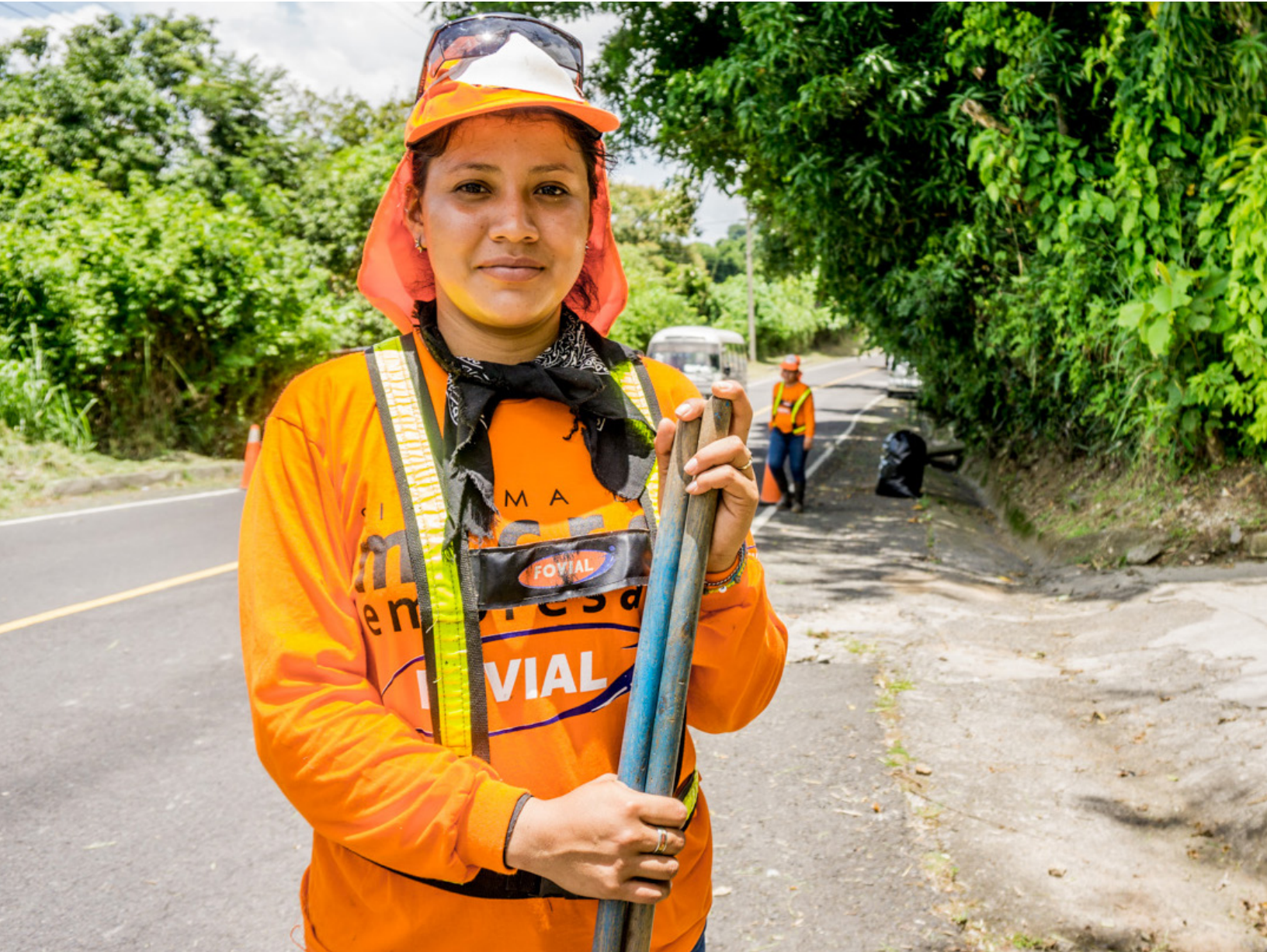
UDP Olocuilta realizando mantenimiento de derecho de vía en Santiago Texacuangos
