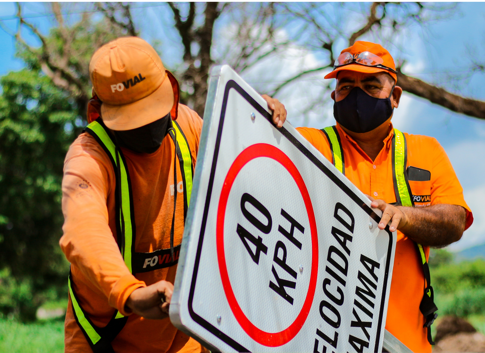
Instalación de elementos de señalización vertical
