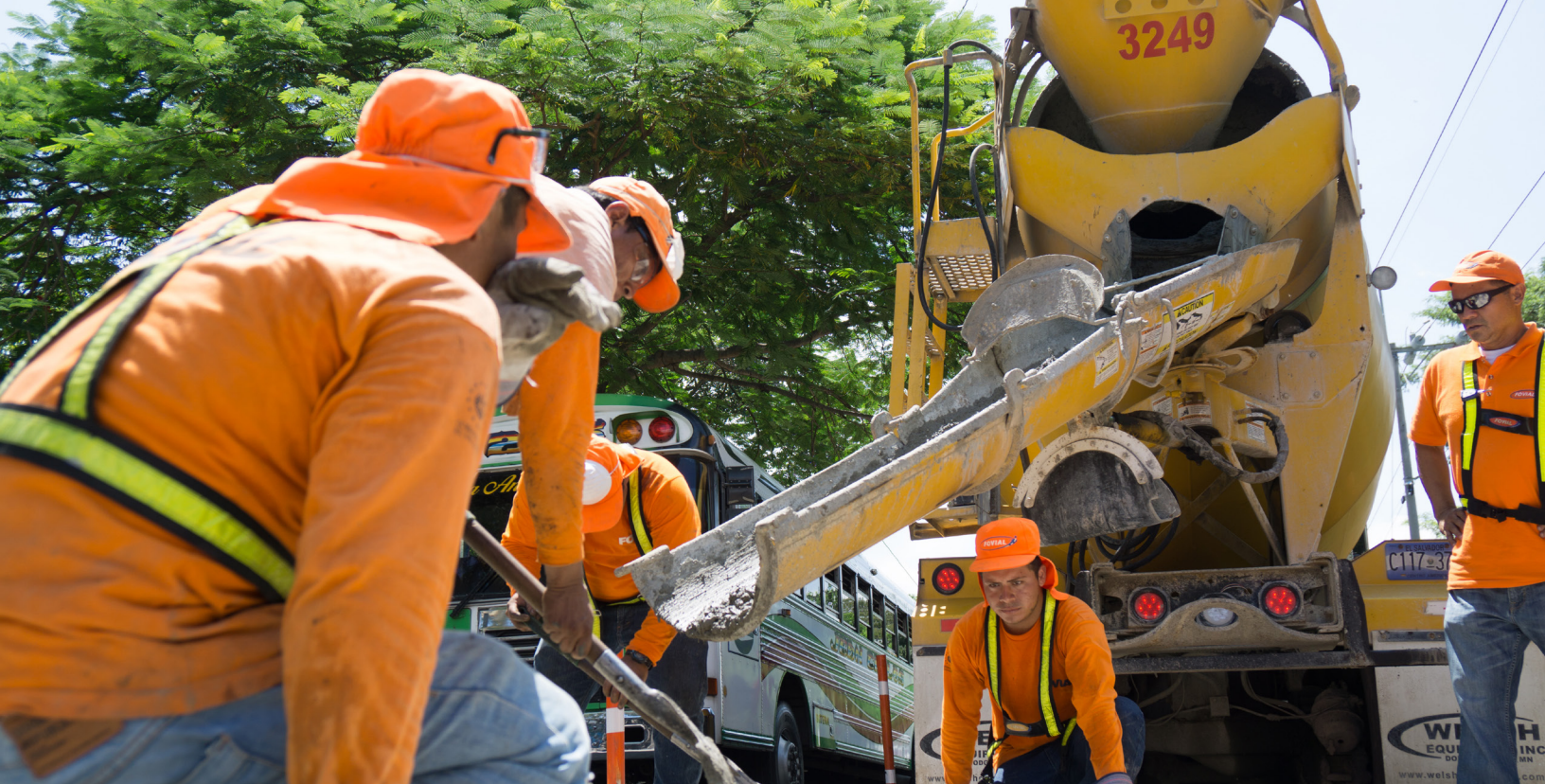
Reparación de losas de concreto carretera Santa Ana - Metapán
