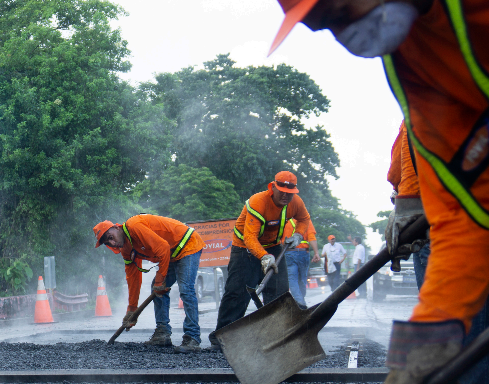
Obra de mitigación en cárcava kilómetro 100 carretera El Litoral, Jiquilisco
