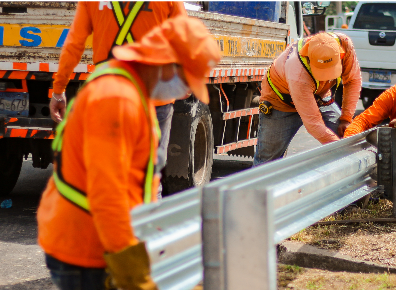
Instalación de elementos de seguridad vial (flex beam)
