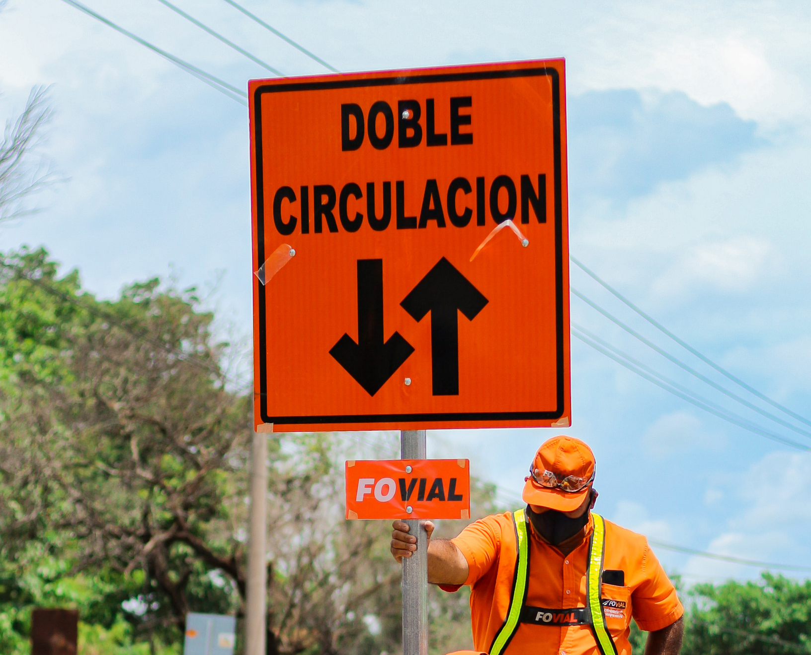
Instalación de elementos de seguridad ocupacional en frentes de trabajo
