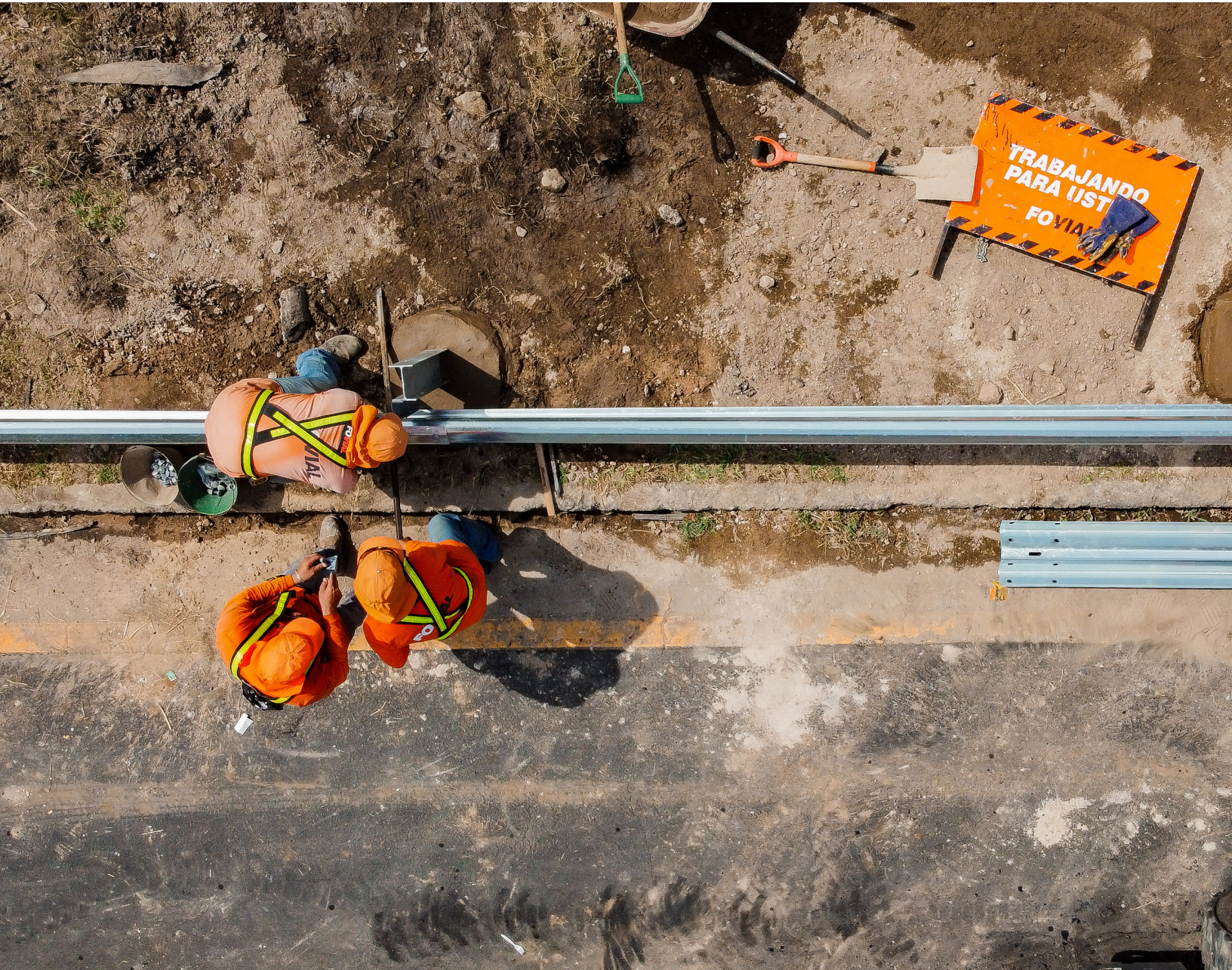
Instalación de flex beam
