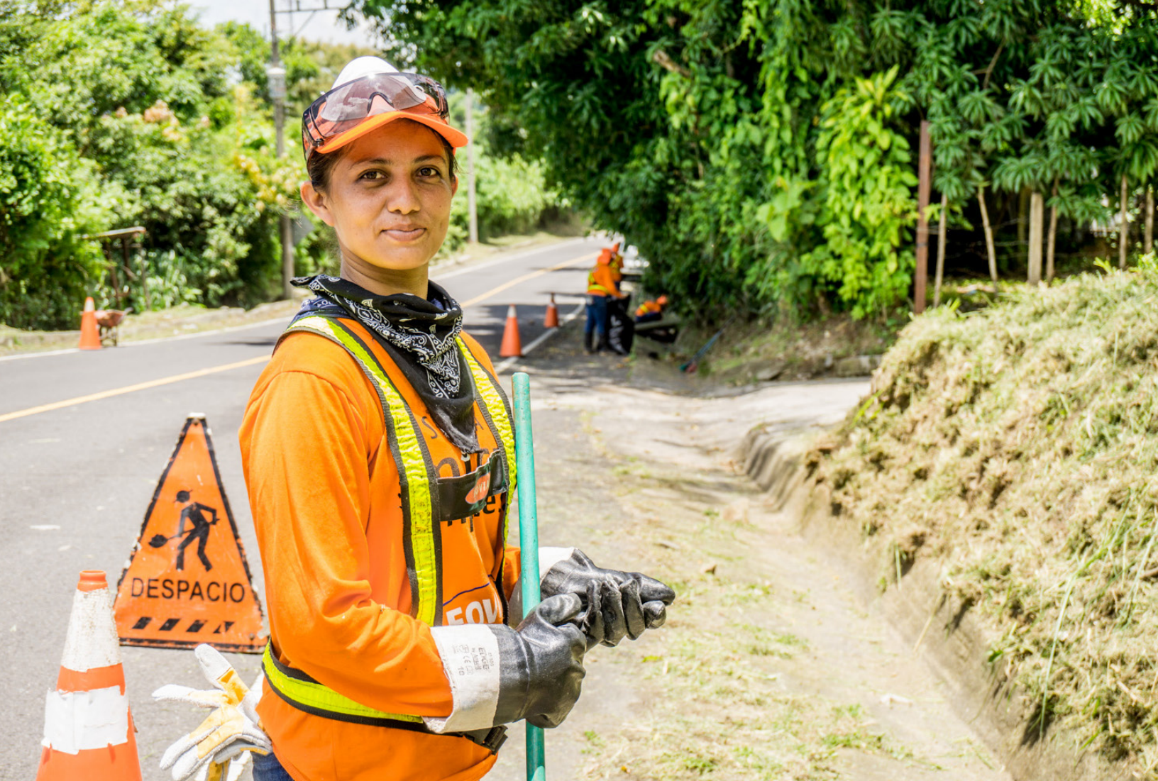
UDP Olocuilta realizando mantenimiento de derecho de vía en Santiago Texacuangos
