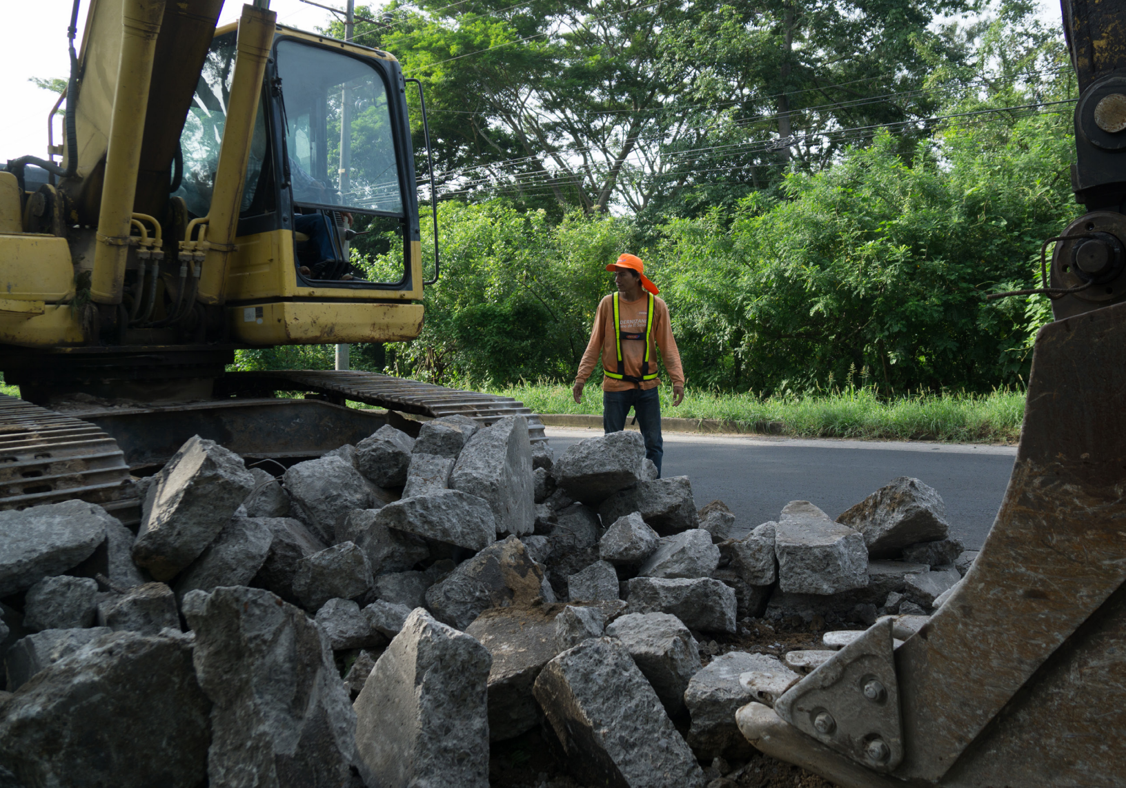
Reciclaje de pavimento La Unión
