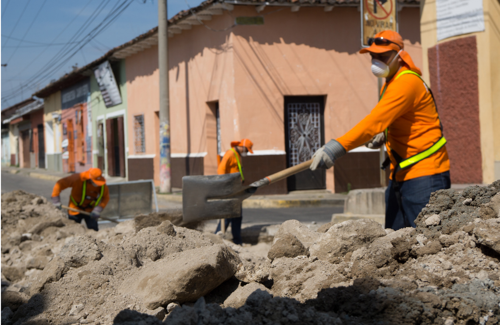
Recuperación de vía en Chalchuapa
