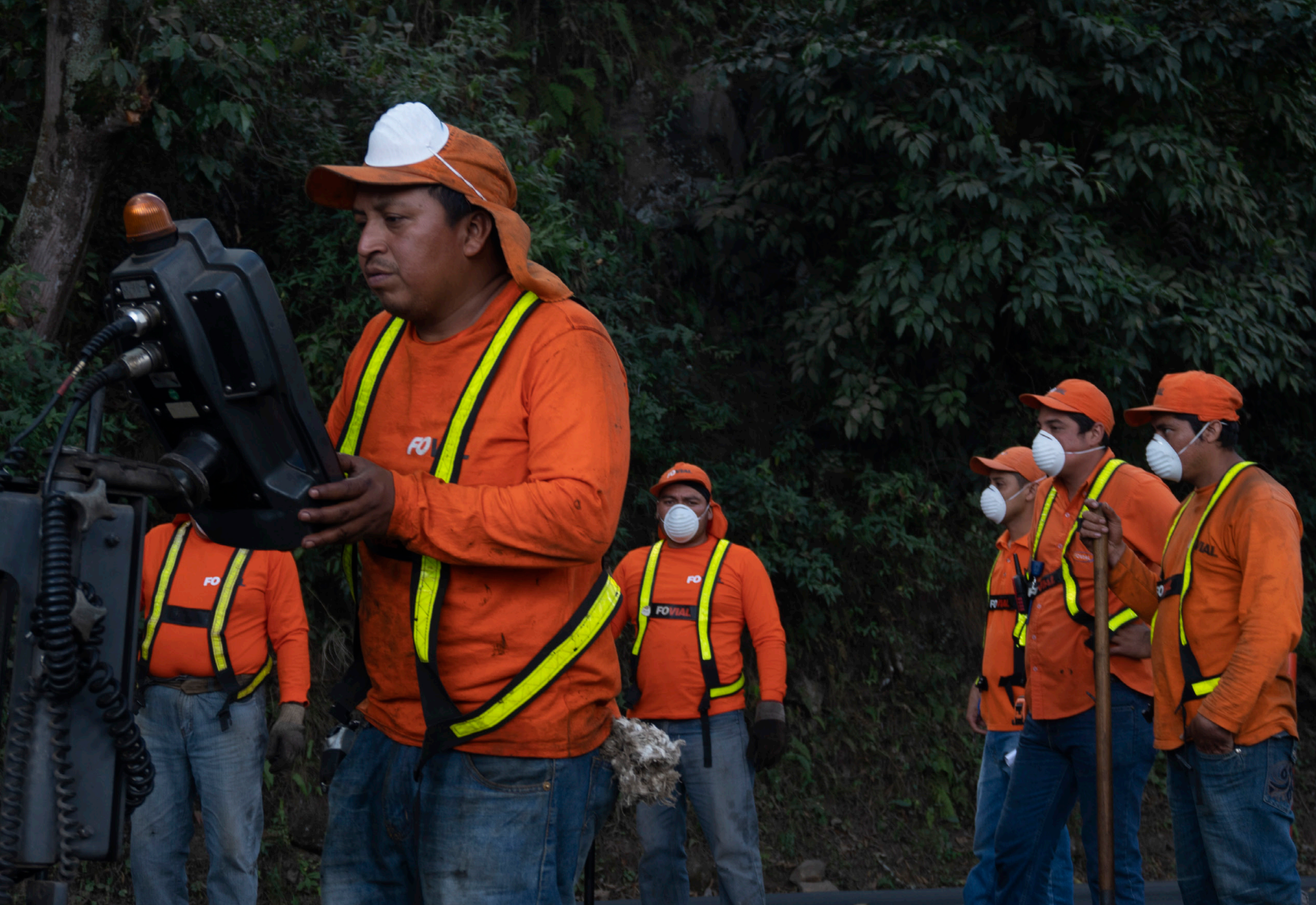
Personal contratista de FOVIAL realiza control de espesores de máquina pavimentadora
