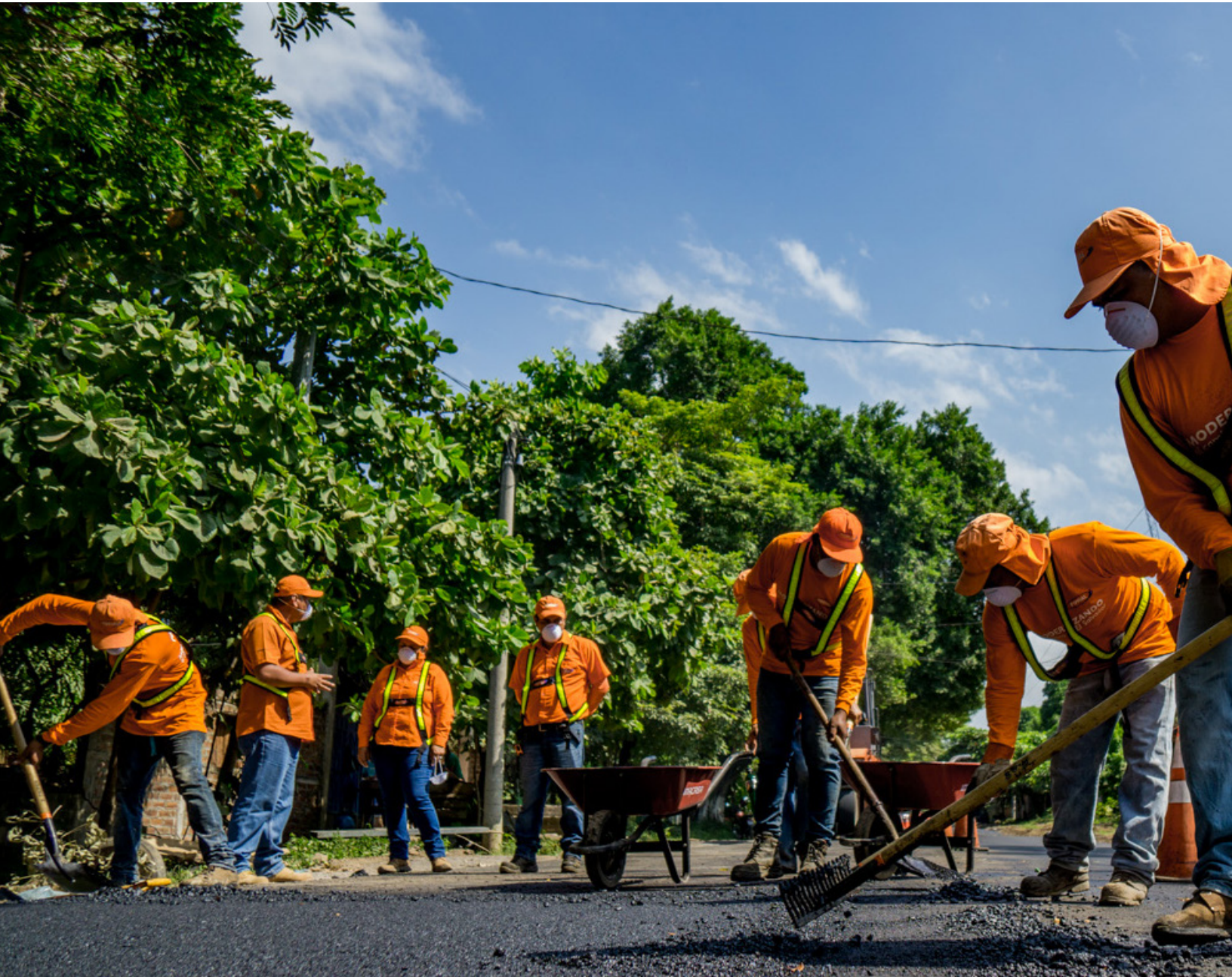
Mantenimiento rutinario carretera Tecoluca - San Vicente
