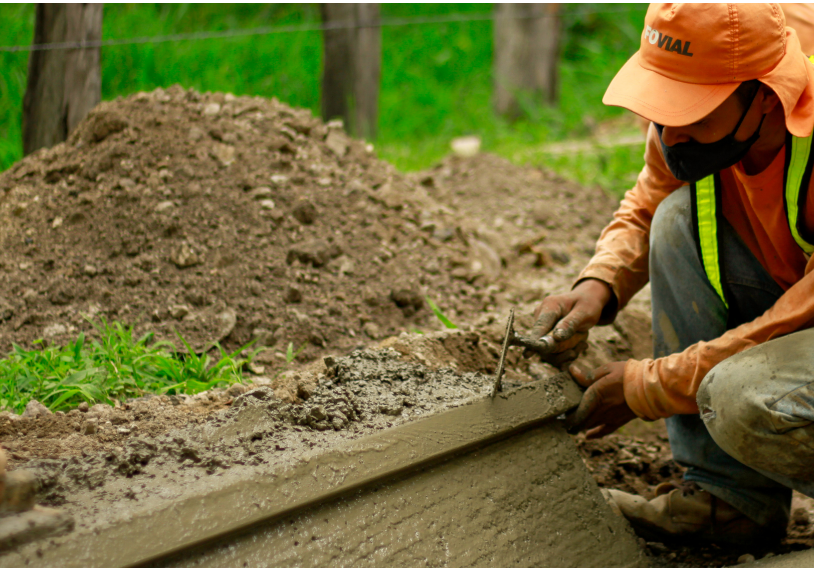
Mantenimiento periódico carretera a El Sauce - Concepción de Oriente
