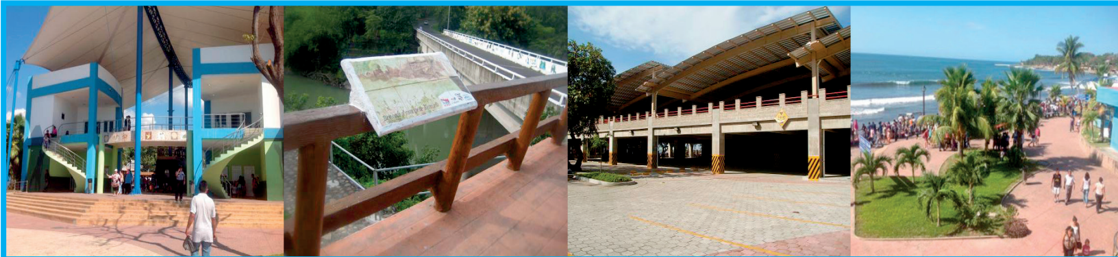
Edificio Administrativo Complejo Turístico Puerto de La Libertad
