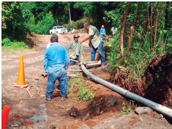
Instalación de tubería
