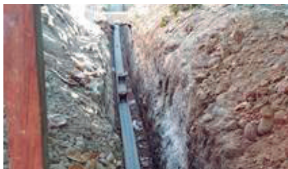
Instalación de tubería
