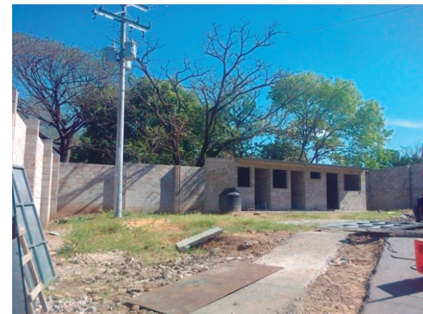
Construcción de caseta de controles
