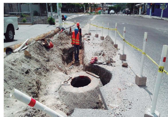
Cambio de tubería y aterrado
