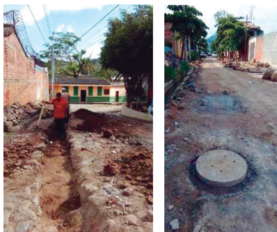
Elaboración pozo de visita
