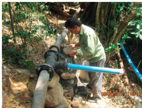
Instalación de tubería de hierro fundido
