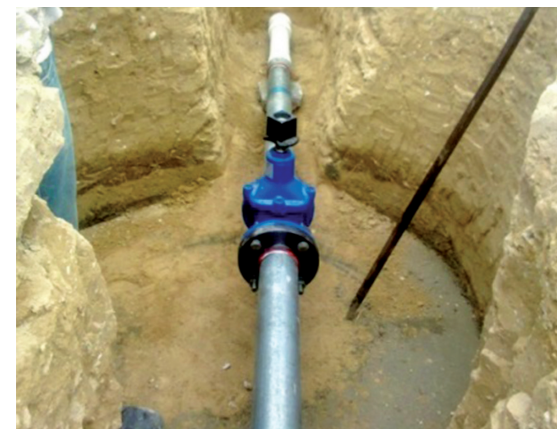
Sustitución de tuberías de agua potable en urbanización El Pepeto, Soyapango
