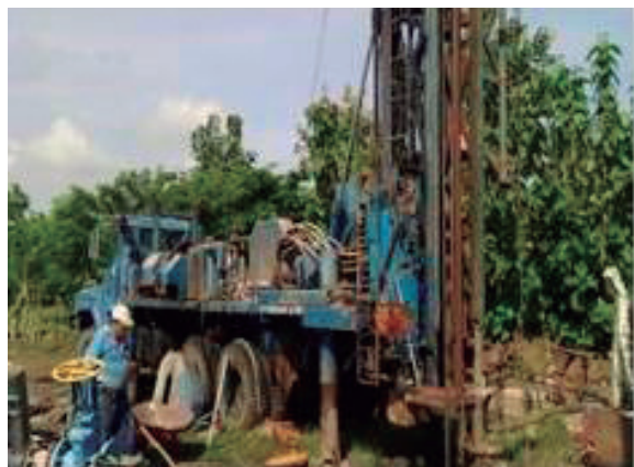
Máquina de perforación de ANDA
