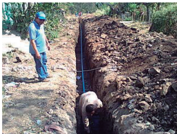
Instalación de tubería
