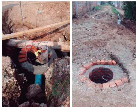
Elaboración de pozo de visita y zanja
