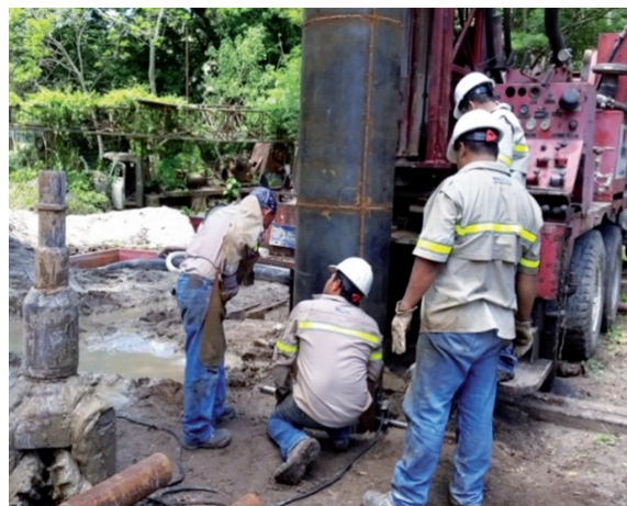
Trabajos de perforación de pozo #5 en sistema de pozos Guluchapa
