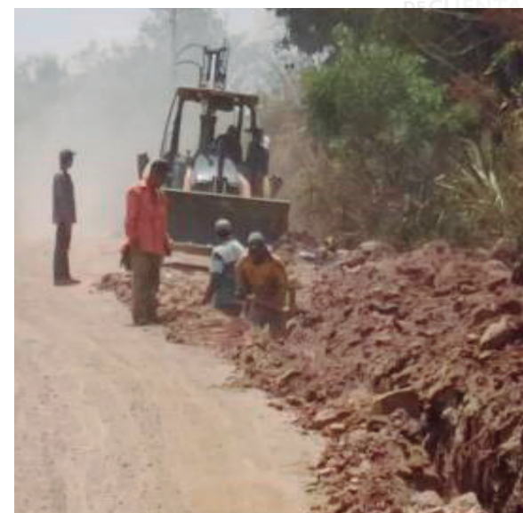
Excavación para instalación de red de distribución
