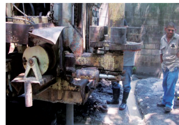
Trabajos de perforación de pozo #3, San Juan Opico
