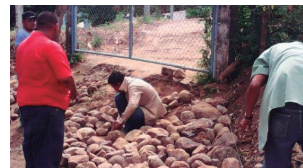
Colocación de piedra entrada a planta
