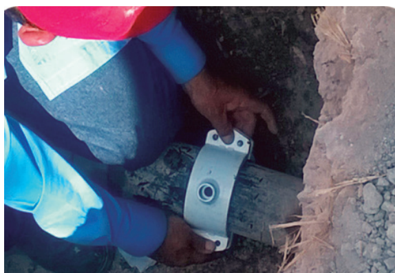
Instalación de reductor
