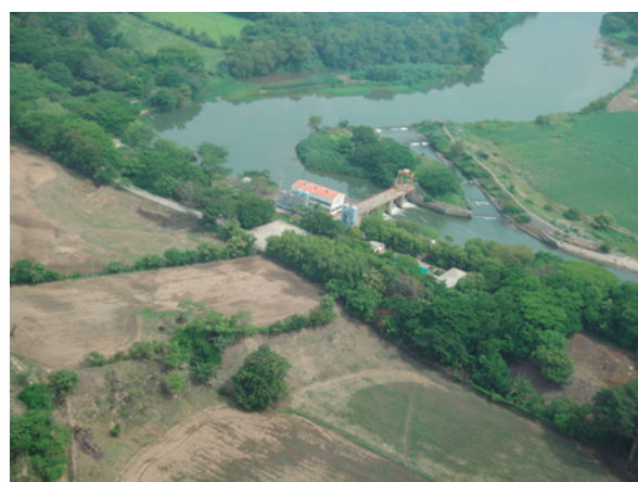
Foto aérea planta potabilizadora Las Pavas
