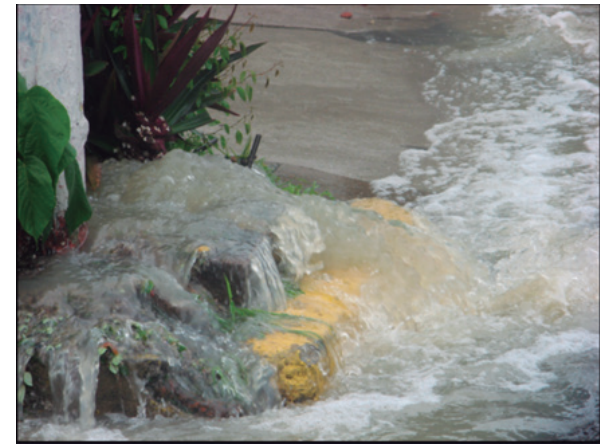
Rebalse de aguas negras por obstrucción en colector
