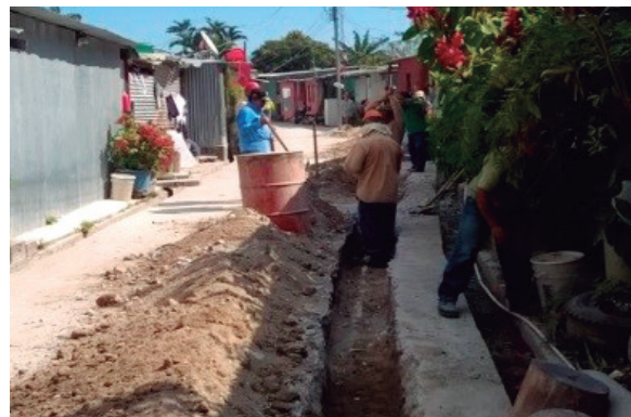
Elaboración de zanja
