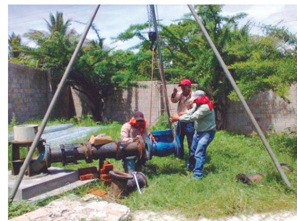
Instalación de cabezal de descarga
