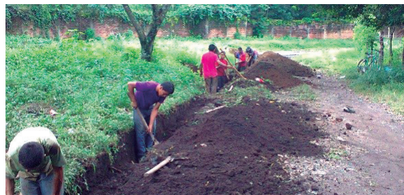
Obras de terracería en comunidad
