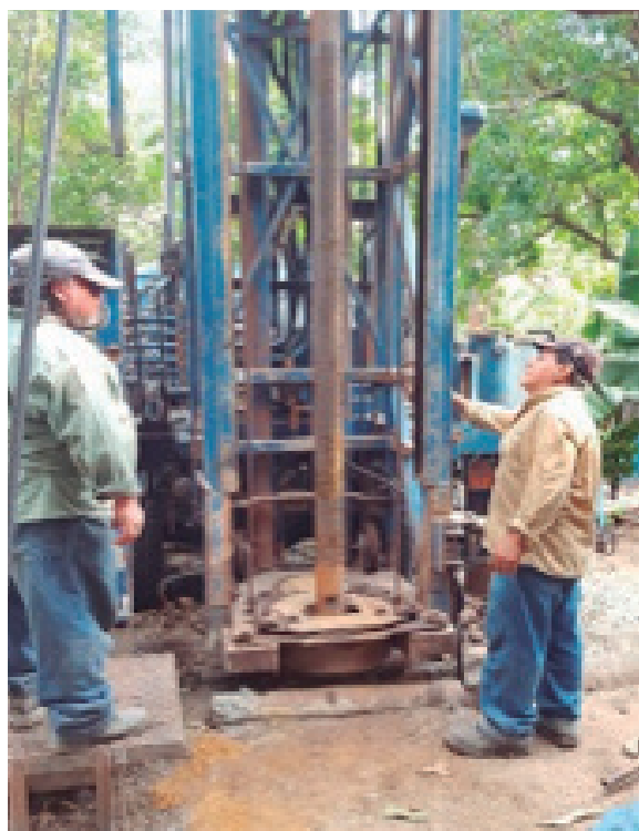
Máquina de perforación de ANDA
