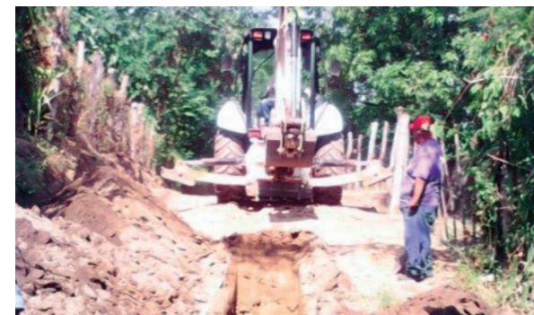
Elaboración de zanja
