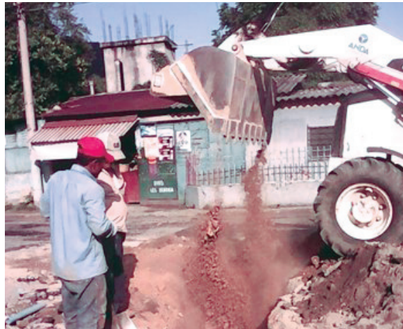
Compactado de tubería
