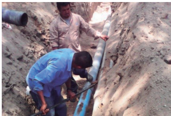
Instalación de tubería PVC
