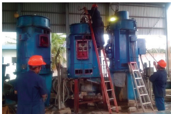
Montaje de equipo de rebombeo en estación de bombeo 1
