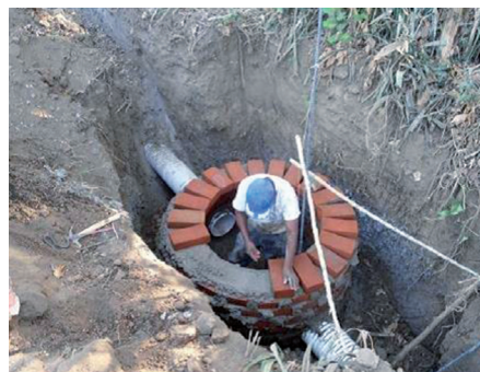
Construcción de letrinas y sistemas de disposición de aguas grises en comunidades Santa María I y II, Santa Ana.
