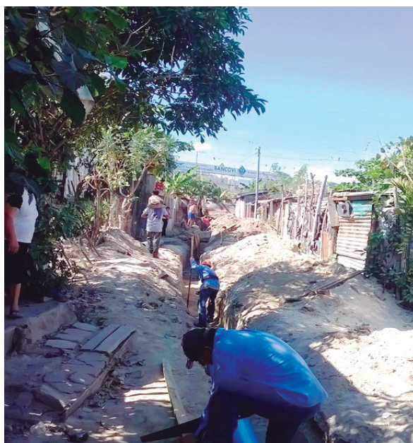
Instalación de tubería
