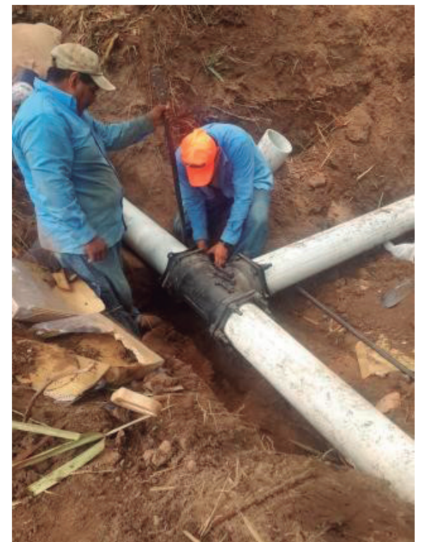
Instalación de tubería de 8 pulgadas de diámetro
