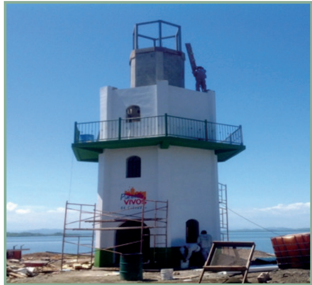
Avance de la obra Faro Turístico, Municipio de La Unión.
