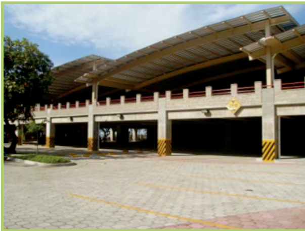
Primer Nivel del Estacionamiento
