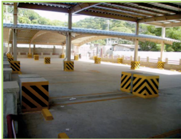
Segundo Nivel del Estacionamiento
